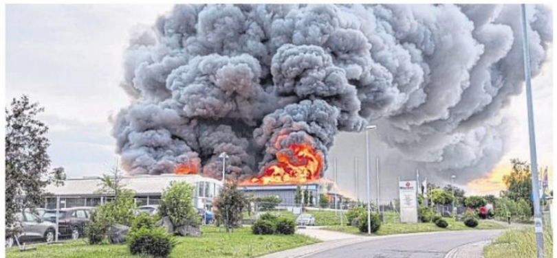
Riesige Rauchwolke über Kottenheim: An Pfingstsonntag ist ein Industriegebäude abgebrannt.
