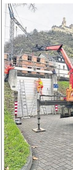
Am Samstag wird am Pegel Kaub mit einer Höhe von 6 Metern gerechnet, in Braubach sind es 6,60 Meter. Hier hat man mit der Errichtung von Schutzbauten für die Altstadt begonnen. Foto: Heinz Scholl
